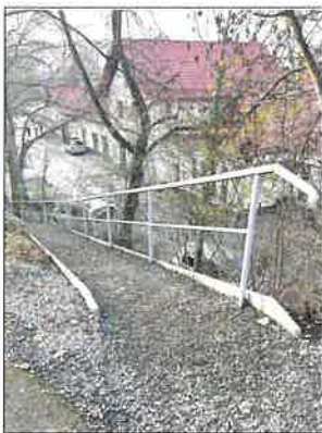
Opravená pěšina u zadnotřebského nádraží. Foto Petra FRÝDLOVÁ
